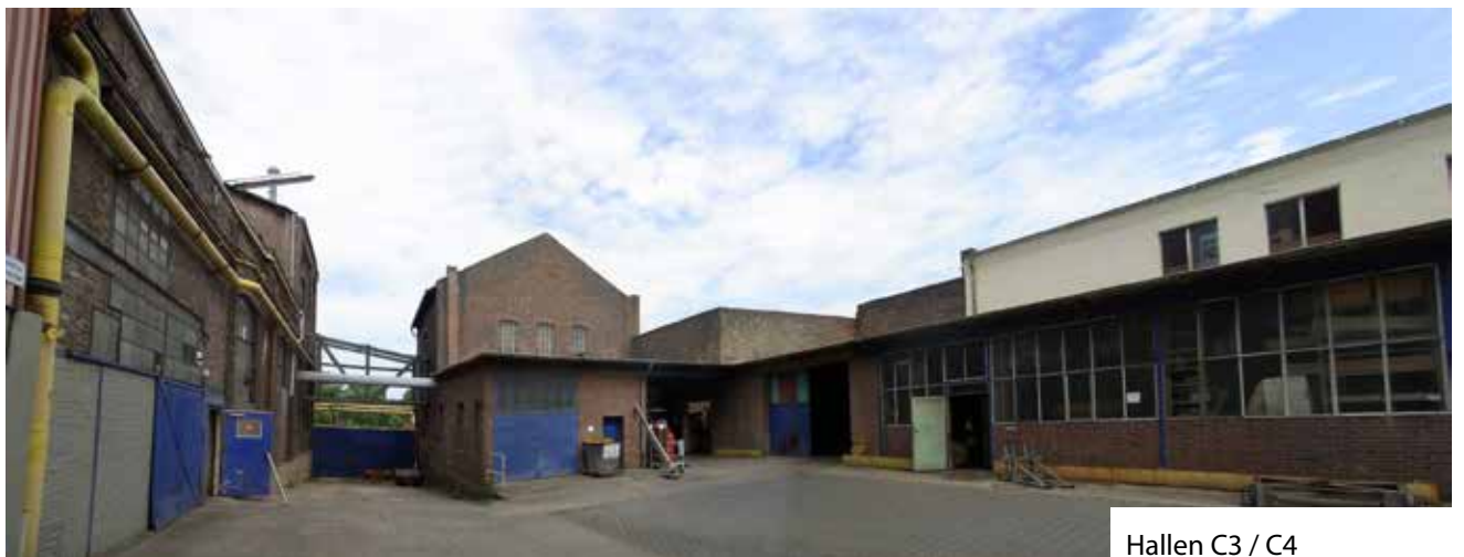
Hafenstraße von Norden
